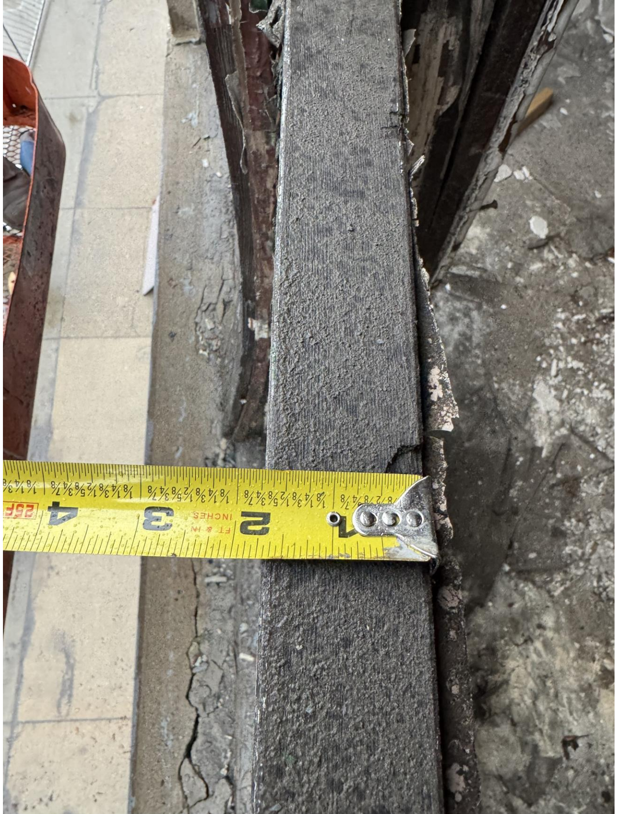
Photo W14 (Sash Top Rail)
