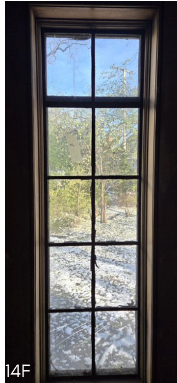
Broken Panes: None
