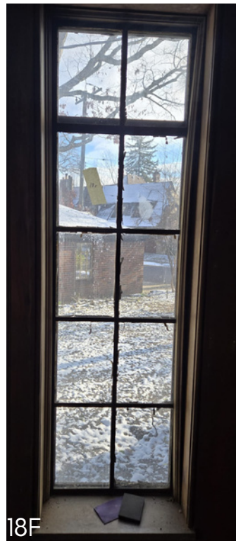
Broken Panes: None
