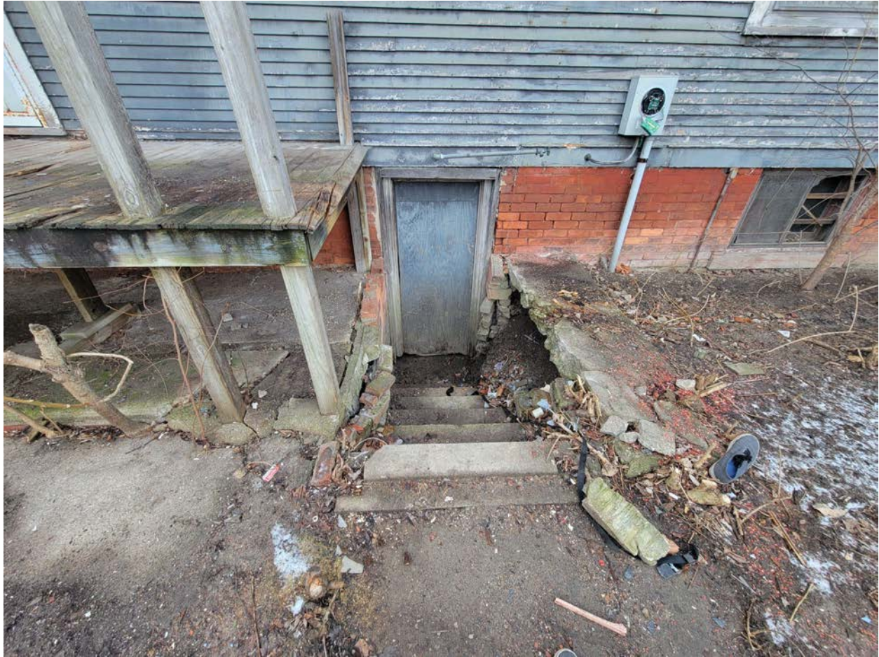
Basement Door Detail
