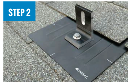
STEP 2 INSTALL L-FOOT
