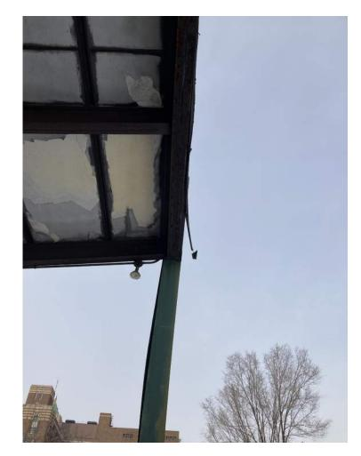
NOTE TORSION TWISTING OF EXISTING STEEL GIRDER
