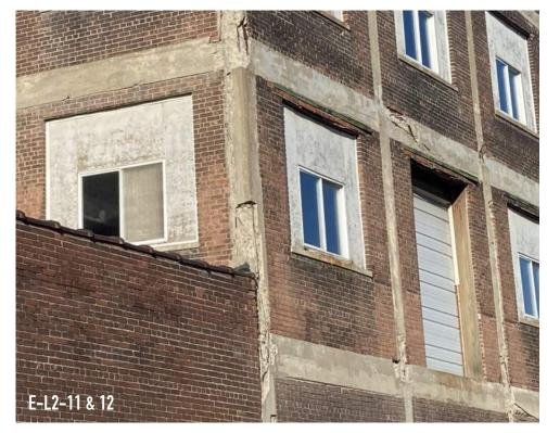
NOTE CRACKED MASONRY ABOVE FAILING LINTEL
