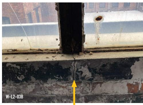
NOTE STEEL CORROSION IN CENTER MULLION AND **EXPANDING RUST PACK**
