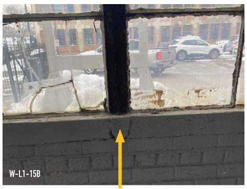
MOST LINTELS AND STEEL FRAMES HAVE SIGNIFICANT CORROSION - EXPANDING RUST PACK IS CAUSING CRACKING AT CONCRETE SILL.
