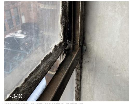
NOTE CORROSION OF OPERABLE PORTION OF WINDOW
