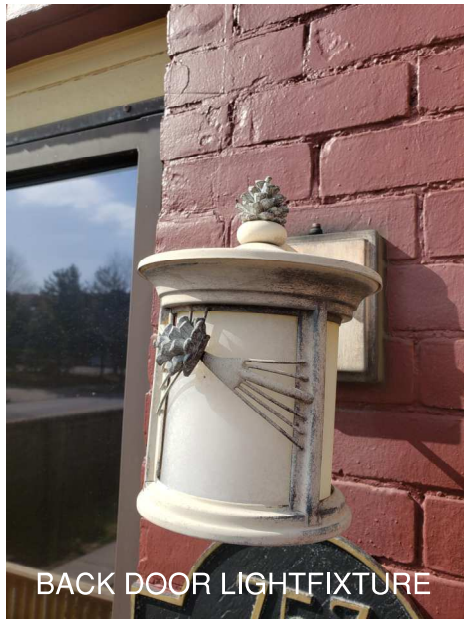
BACK DOOR LIGHTFIXTURE
