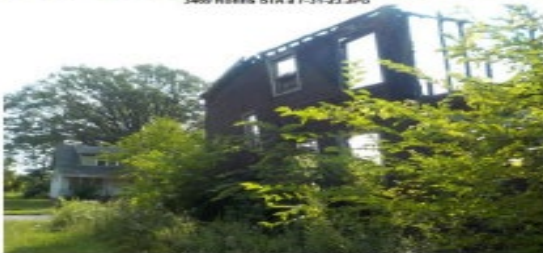
3469 Rohns STA c rear 7-31-23.JPG
