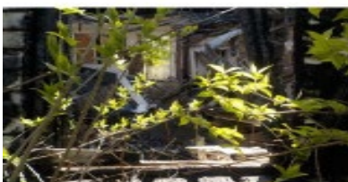
19267 Andover STA c interior 5-4-23.JPG
