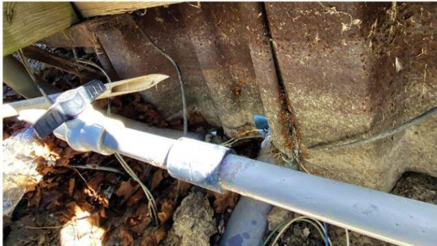
BROKEN DUCT FOR POWER LINE FEEDS TO POWER
