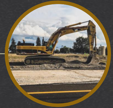
CIMIENTOS Y CONSTRUCCIÓN:
